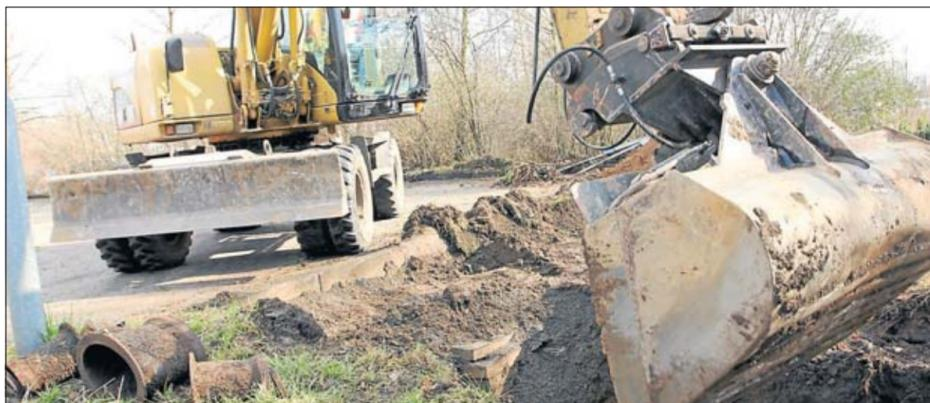
Vorsichtig legt Klaus Friese mit der Baggerschaufel | damit sie vom Netz getrennt werden kann. Anschließend ist der Schacht an der Reihe. Foto: Sonja Gruhn
