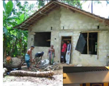
2006 vom Lions Club Löhne in Mirissa (Sri Lanka) finanziertes Haus für Opfer des Tsunami
